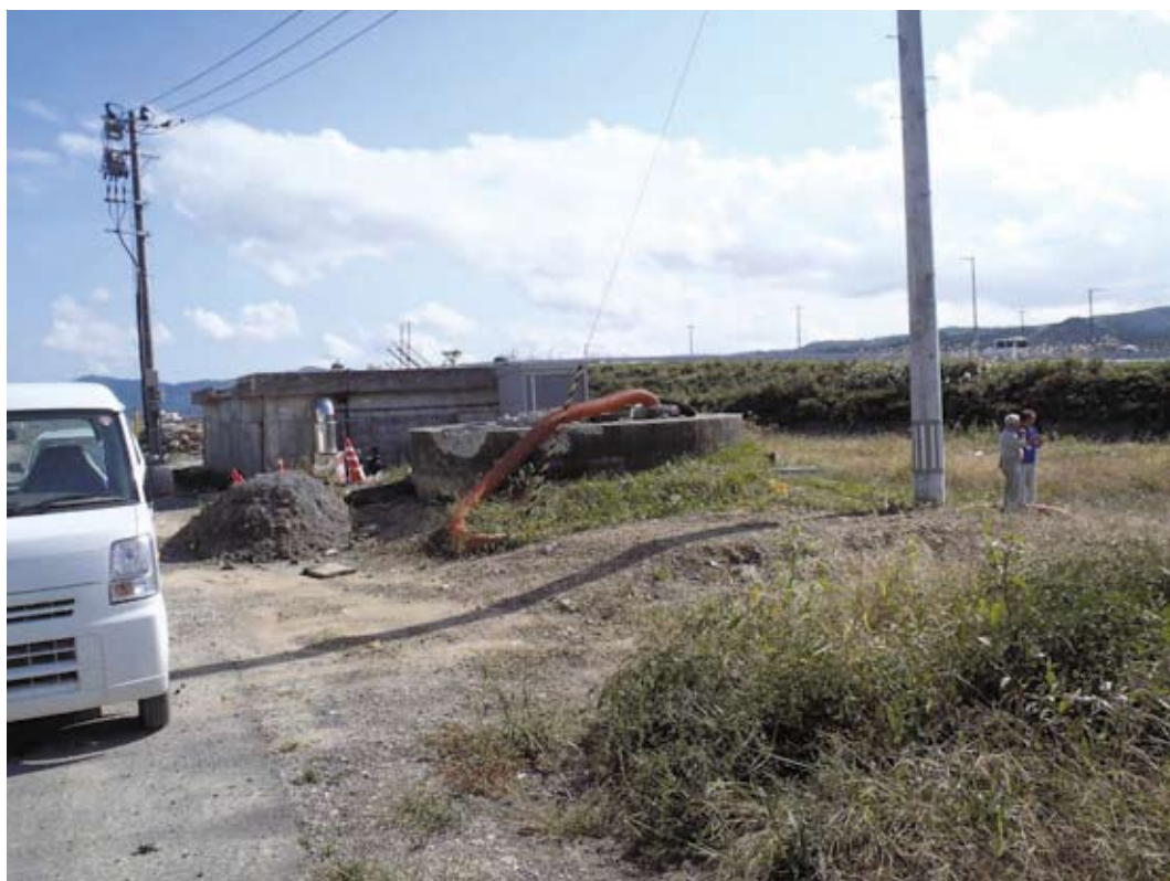
写真宮－３ 津波浸水により塩水化した井戸（南三陸町）
