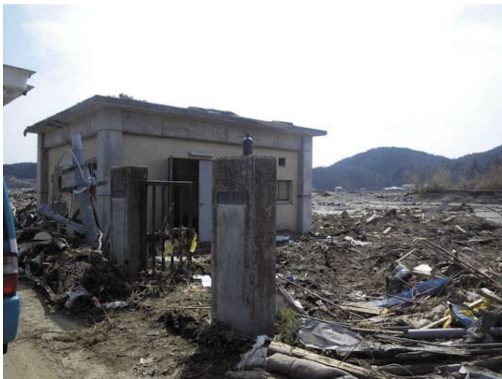
写真岩－2 陸前高田市 竹駒第2水源井戸
