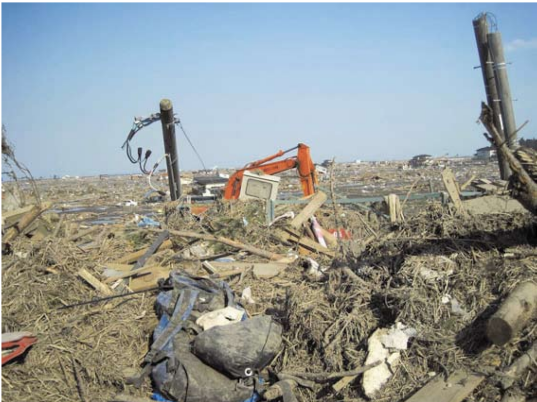
写真宮－５ 津波により RC 製ピットや電柱、制御盤が流失した井戸（山元町）
