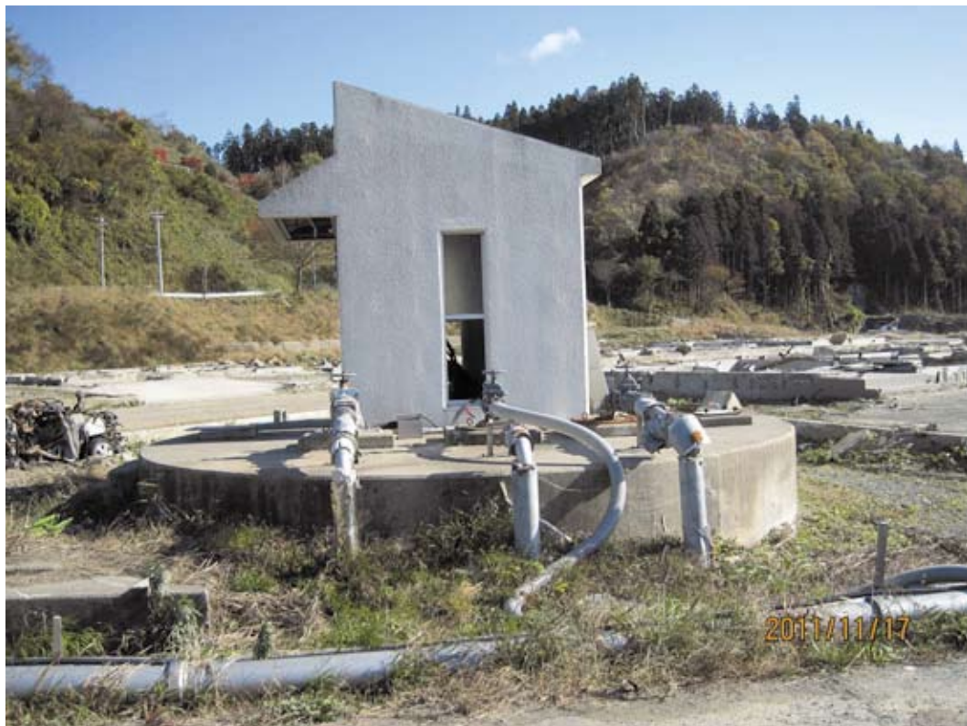
写真宮－２ 津波浸水により塩水化した井戸（南三陸町）
